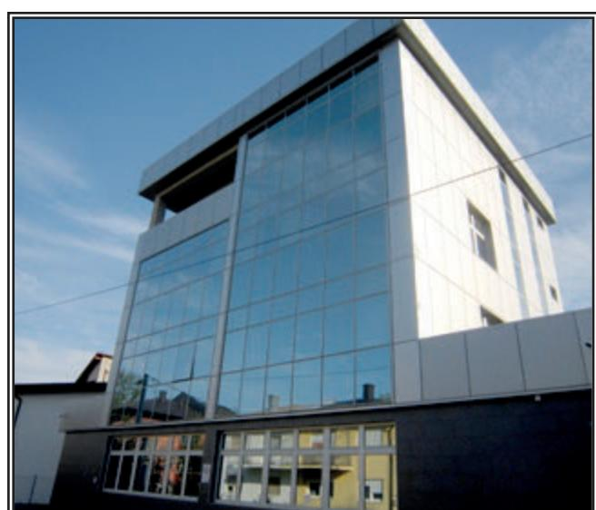
Doboj, Verwaltungsgebäude der Eisenbahn - M3® halbstrukturelle Vorhangfassade/ Façade semi-structurelle, Alubond Fassade / J-bond façade
