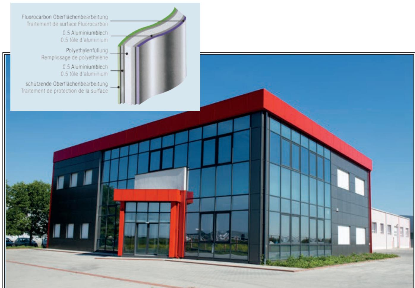
Les façades en verres sont une tendance contemporaine dans la construction des ouvrages d'affaires. Elles sont fabriquées avec profils en aluminium, qui constituent la construction portante de la façade et qui sont dimensionnées par le calcul statique. Les spécifications détaillées des matériaux utilisés lors de la fabrication des façades sont présentées dans le chapitre "Fenêtres et portes en aluminium"
